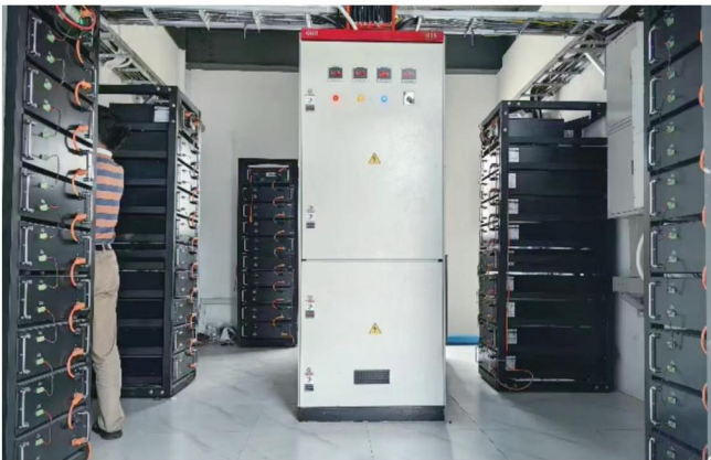
Usine textile de Yangon (Myanmar) : 5 batteries haute tension fonctionnant en parallèle
