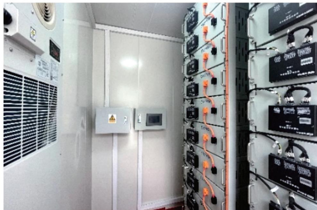
Réglage de fréquence de centrale : 9 MW / 4,5 MWh
