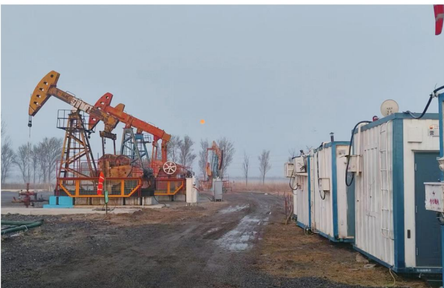
Armoire intégrée de stockage d'énergie pour champs pétrolifères à l'étranger : 350 kW / 460 kWh
