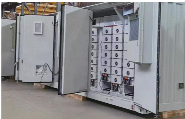
Centrale de stockage d'énergie partagé Wen-shou : 16 MW / 32 MWh
