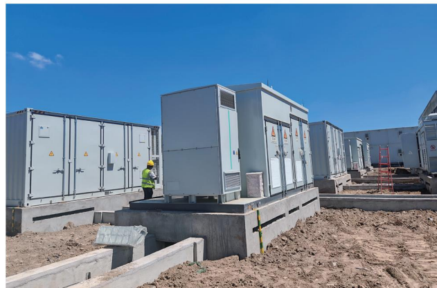
Micro-réseau intelligent : produit de stockage d'énergie en conteneur 630 kW / 1 MWh
