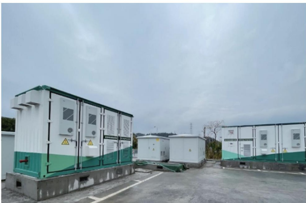
Station de recharge avec stockage d'énergie : 30 MW / 60 MWh
