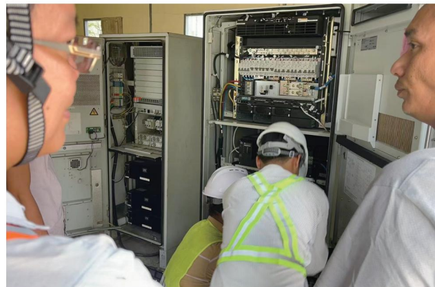
Batteries pour stations de base ZTE et Huawei : 48 V 150 Ah
