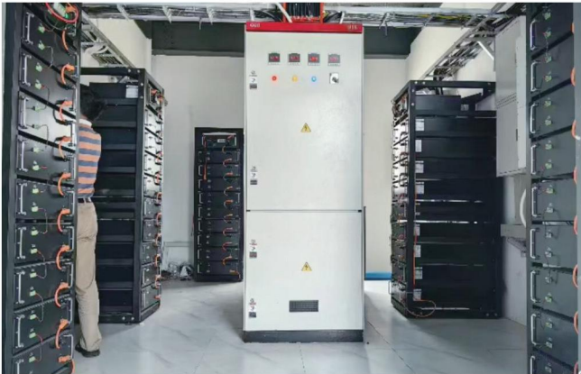
缅甸仰光纺织厂5台高压电池并机
